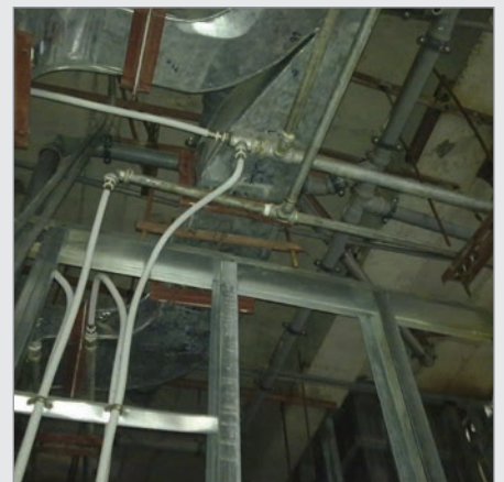
عدم اتصال رانر بالایی به سقف یا زیرسازی قوطی
