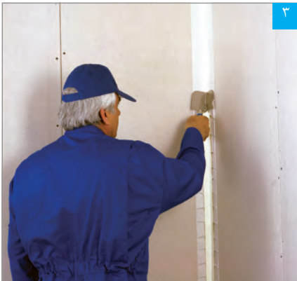
تثبیت و شکل دهی نوار درزگیر با کاردک زاویه خارجی
