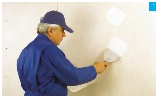
اجرای بتونه در محل پیچ‌ها
