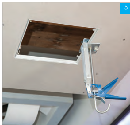
تنظیم و ثابت کردن محل نصب دریچه
