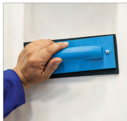
مرطوب کردن سطح دیوار با اسفنج نمدار
