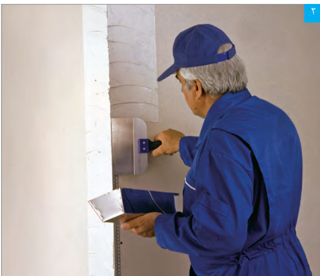
اجرای بتونه روی سازه محافظ گوشه
