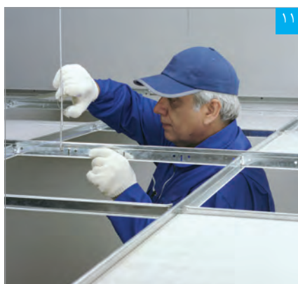
تنظیم ارتفاع سقف
