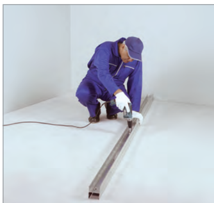
اجرای سازه سقفی دوتایی
