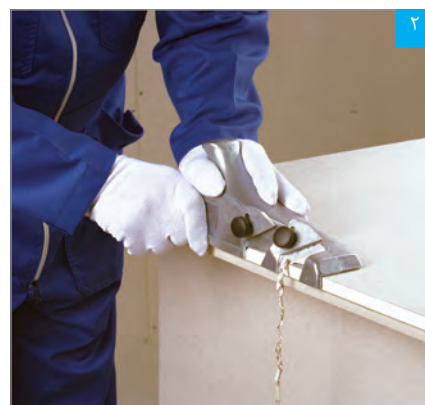
اجرای پخ با پخ زن
