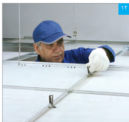
قراردادن گیره‌های مخصوص نگهدارنده تایل
