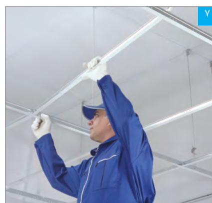
اجرای سازه‌های فرعی T1200
