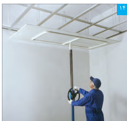
استقرار پنل با استفاده از بالابر
