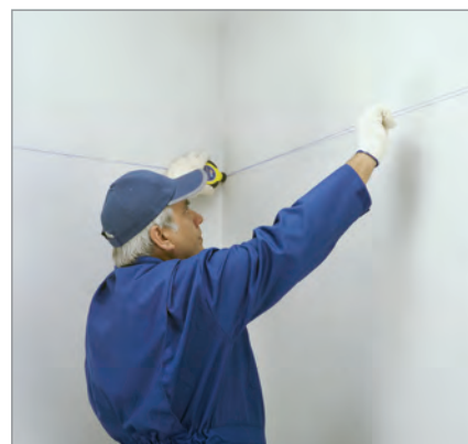
مشخص کردن محل نصب سازه تراز باربر با ریسمان رنگی
