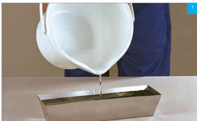
ریختن آب در ظرف تهیه بتونه
