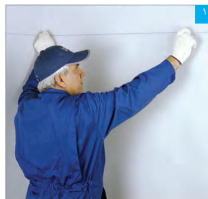
۱ مشخص کردن محل نصب سازه تراز با ریسمان رنگی
