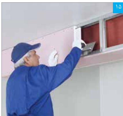
اجرای بتونه درزگیر بر روی نیمه دیگر پنل پشت بند درز (پس از خشک شدن بتونه درزگیر نیمه اول)
