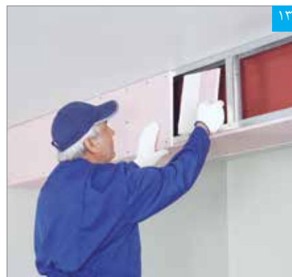
استقرار پنل پشت بند درز
