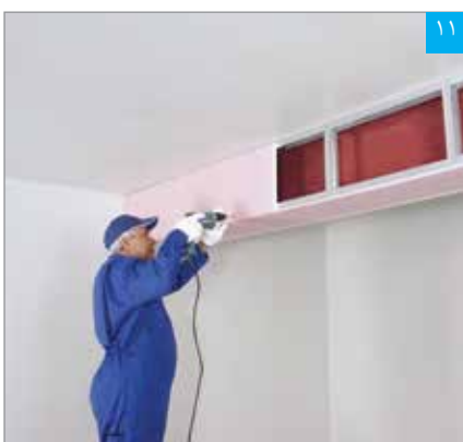
اجرای پنل جانبی
