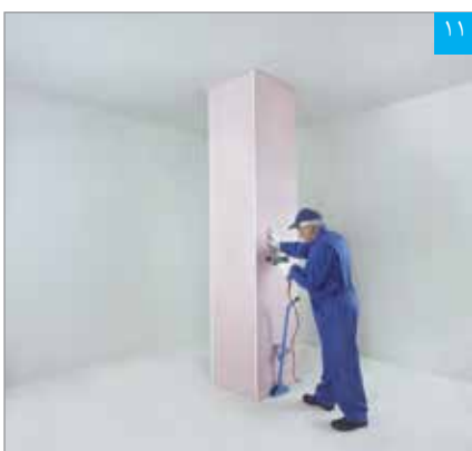
۱۱ تکمیل پوشش کاری لایه دوم
