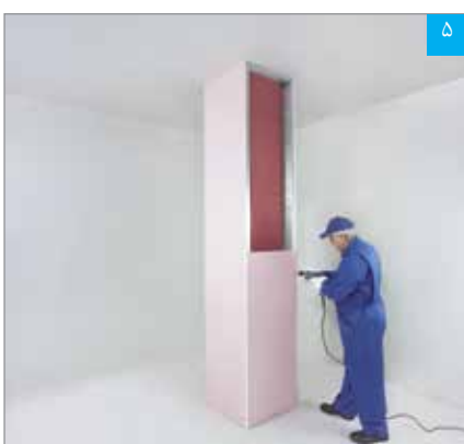
۵ اجرای پنل‌های لایه اول
