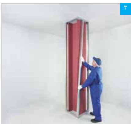
۳ استقرار استاداها در رانرهای کف و سقف
