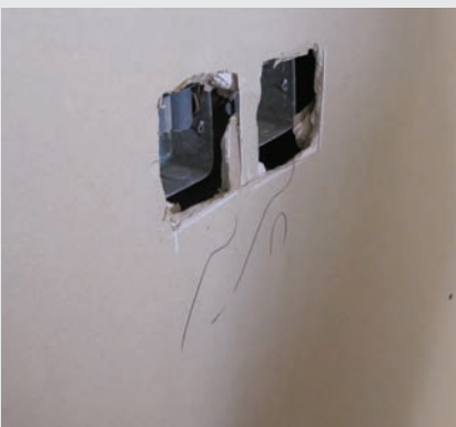
برش نامناسب پنل
