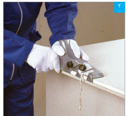
اجرای پخ با پخ زن
