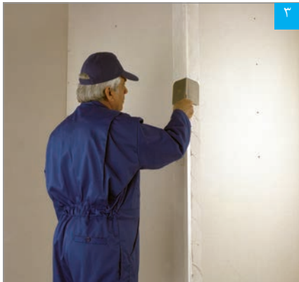
تثبیت و شکل دهی نوار محافظ گوشه با کاردک زاویه خارجی
