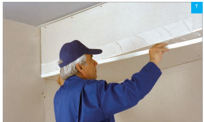
قرار دادن نوار درزگیر بر روی بتونه
