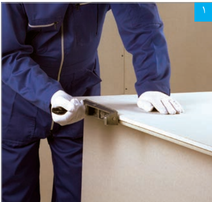
پرداخت لبه برش‌خورده با رنده
