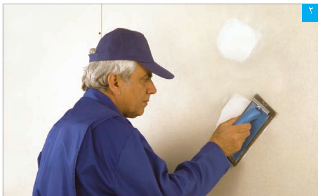
پرداخت سطح بتونه خشک
