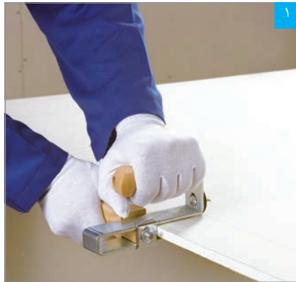
برش پنل با دستگاه برش قرقه‌ای
