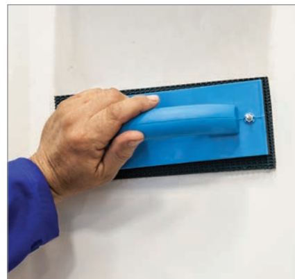
مرطوب کردن سطح دیوار با اسفنج نمدار
