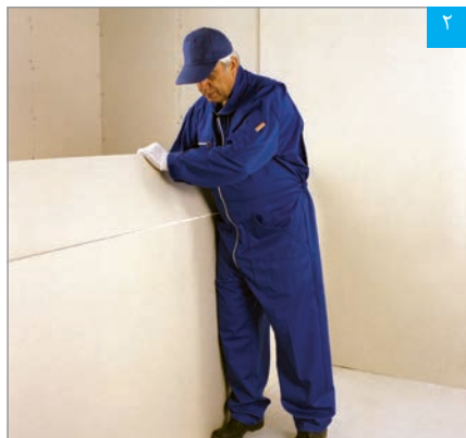
شکستن پنل در محل برش
