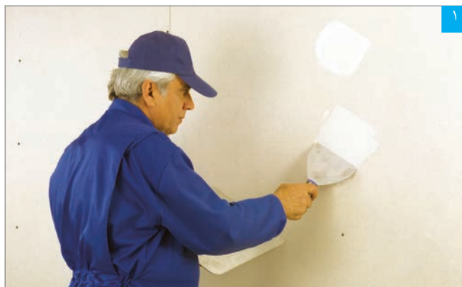
اجرای بتونه در محل پیچ‌ها
