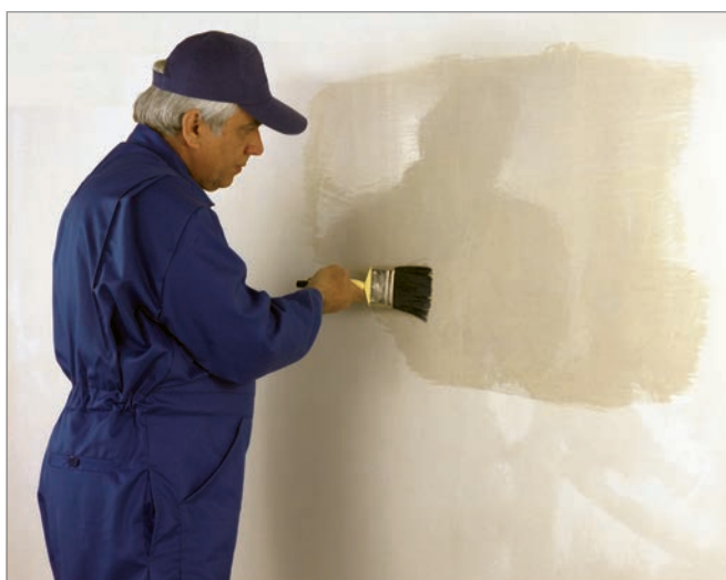
اجرای لایه پرایمر بر روی ماستیک قبل از رنگ آمیزی با رنگ روغنی
