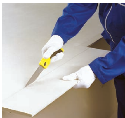
برش پنل با اره دستی
