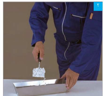
ریختن پودر بتونه در آب
