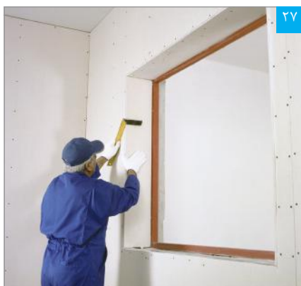
۲۷ تنظیم پنل نواری (گونیا کردن)
