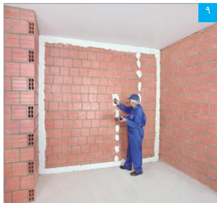
اجرای چانه‌های چسب گچی پنل (بوردفیکس) بر روی دیوار زمینه (در فواصل مرکز به مرکز حداکثر ۳۵ س.م)
