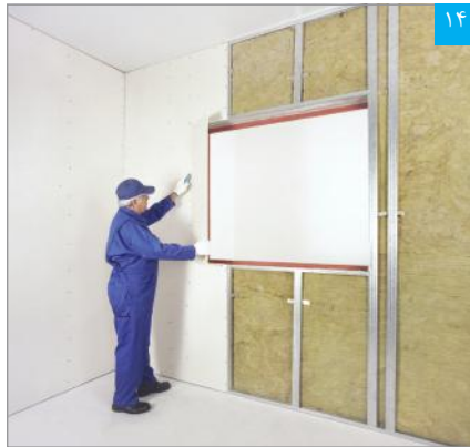
۱۴ برش پنل با استفاده از تیغ برش
