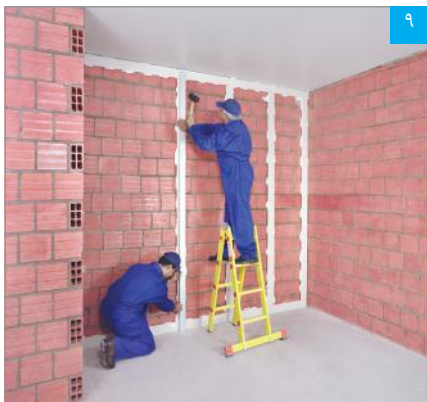
تنظیم نهایی کرم نصب شده با شمشه و چکش لاستیکی
