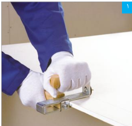
برش پنل با دستگاه برش قرقراهی
