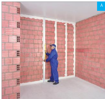
بررسی تراز و تنظیم بودن کرم نصب شده با استفاده از شمشه و تراز
