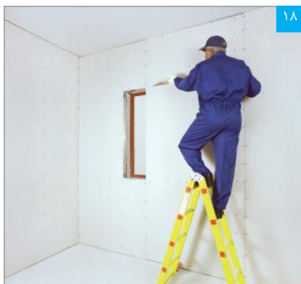
۱۸ برش پنل به صورت «C» شکل (با استفاده از اره)
