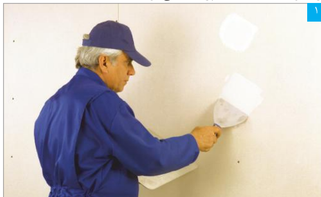
اجرای بتونه در محل پیچ‌ها
