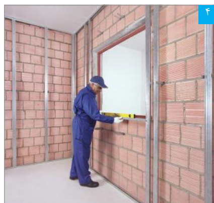
۴ تنظیم سازه قاببندی به وسیله تراز
