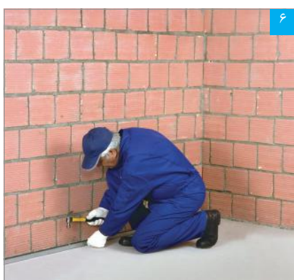
۶ نصب سازه هادی کف
