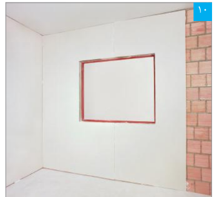
۱۰ پوشش کاری تکمیل شده در ناحیه بیرونی بازشوی پنجره
