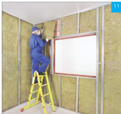
۱۱ اجرای عایق پشم‌معدنی
