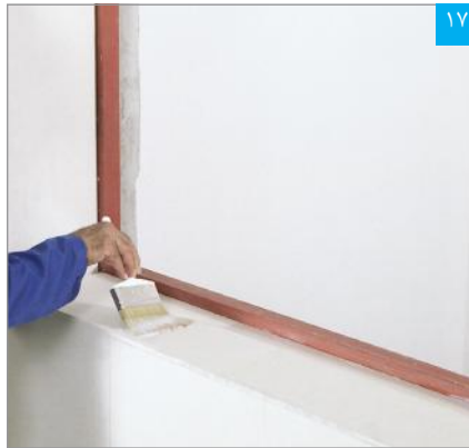
اجرای پرایمر بر روی سطح پنل
