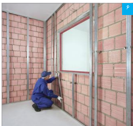
۶ استقرار سازه‌های قائم در سازه هادی کف، سازه قاببندی تحتانی و براکت‌ها
