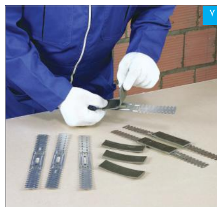
۷ نصب قطعات فوم (عایق) بر پشت براکت‌ها
