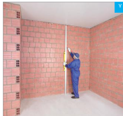
مشخص کردن محل اجرای چانه‌های چسب گچی پنل (بوردفیکس) بر روی دیوار زمینه
