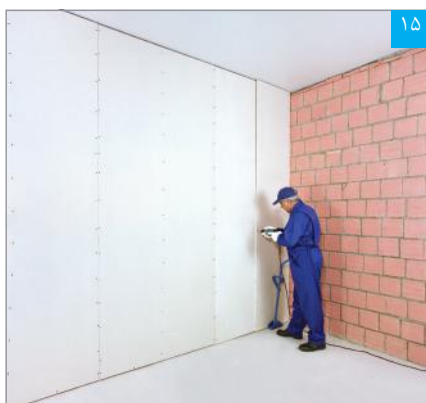
اجرای لایه دوم پنل‌ها؛ ساختار W625.ir (لایه دوم نسبت به لایه اول به صورت حصیرچین اجرا می‌شود)
