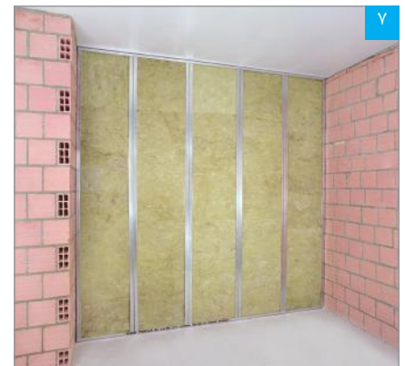
لایه عایق تکمیل شده
