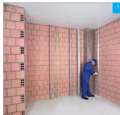
۱ نصب اولین رانر بر روی ساختار جانبی
