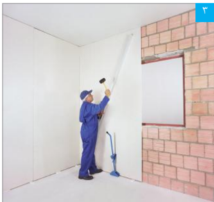
نصب و تنظیم پنل بر روی دیوار زمینه
