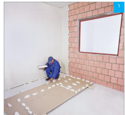
اجرای چانه‌های چسب گچی پنل (بوردفیکس) بر پشت پنل
