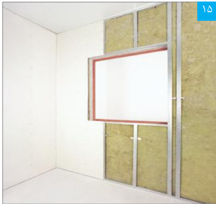
۱۵ در محل بازشوی پنجره، برش پنل به صورت «C» شکل صورت می‌گیرد
