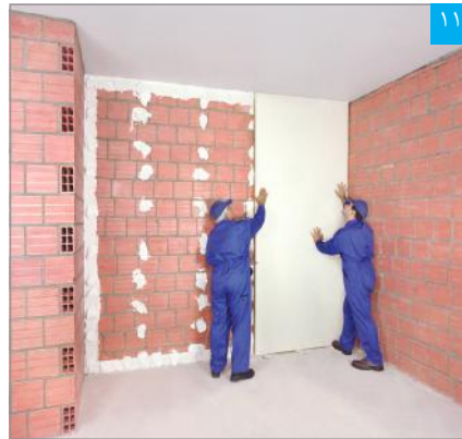
۱۱ استقرار پنل بر روی دیوار زمینه
