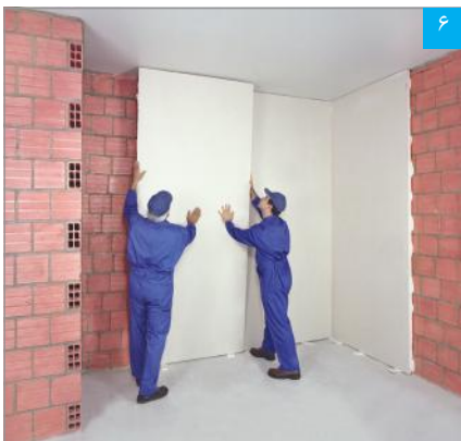
۶ استقرار پنل بر روی دیوار زمینه
