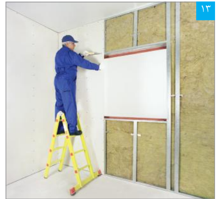
۱۳ برش پنل با استفاده از اره
