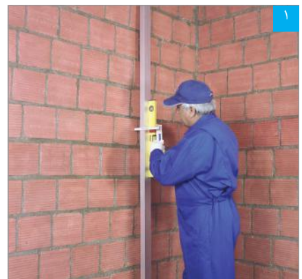
اندازه‌گیری میزان ناهمواری دیوار
