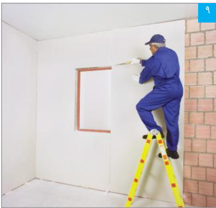
۹ برش پنل به صورت «C» شکل (با استفاده از اره)
