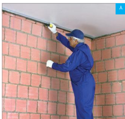
۸ مشخص کردن محل نصب براکت‌ها بر روی دیوار زمینه
