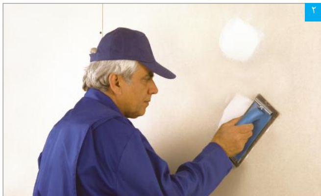
پرداخت سطح بتونه خشک
