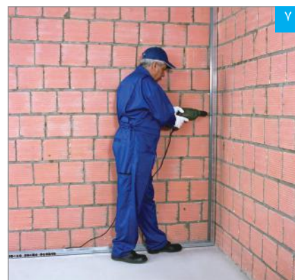
نصب اولین استاد بر روی ساختار جانبی
