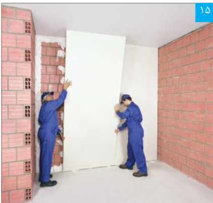
۱۳ پنل‌ها بر روی محور مرکزی ردیف‌های چسب گچی پنل (بوردفیکس) مستقر می‌شوند
