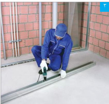
اجرای استادهای دوتایی
