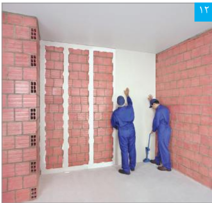
۱۲ نصب پنل با استفاده از جک نگهدارنده
