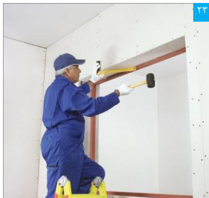
۲۳ تنظیم پنل نواری (گونیا کردن)
