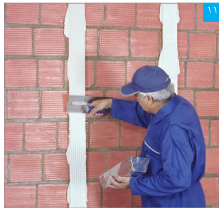
۱۱ اجرای لایه بتونه درزگیر بر روی کرم‌ها با استفاده از ماله دندان‌دار
