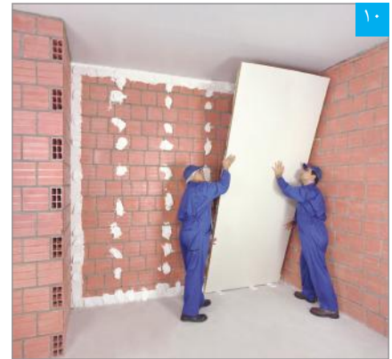
۱۲ پنل به سادگی توسط دو نفر قابل بلند کردن است
