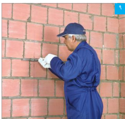
۹ نصب براکت بر روی دیوار زمینه
