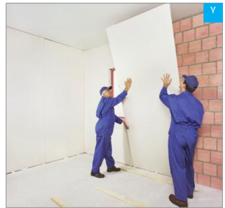
۷ استقرار پنل بر روی دیوار زمینه
