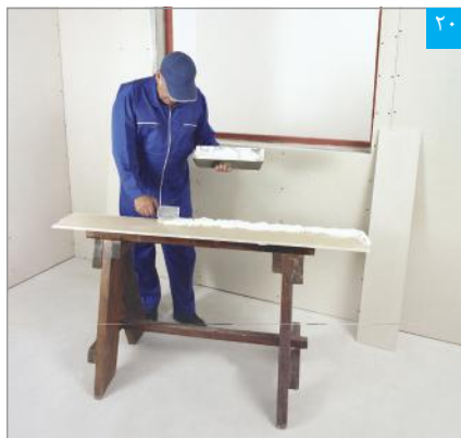
۲۰ اجرای چسب گچی پنل (بوردفیکس) بر پشت پنل نواری (برای پوشش کاری ناحیه داخلی دور بازشوی پنجره)
