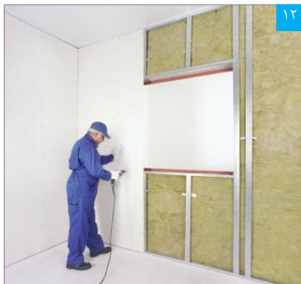
۱۲ نصب پنل بر روی زیرسازی
