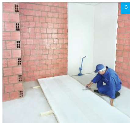
۵ اجرای لایه بتونه درزگیر (به صورت شانه‌ای) بر پشت پنل مرکب PS
