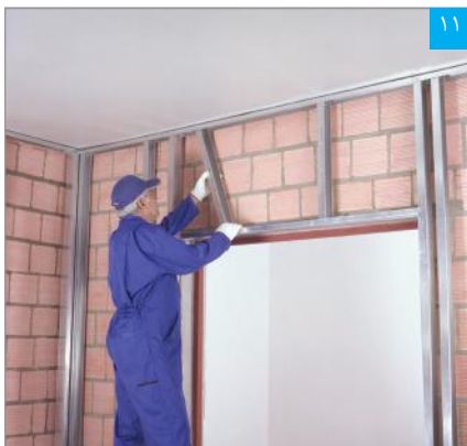
۱۱ استقرار استاداها در رانر سقف و رانر قاببندی فوقانی
