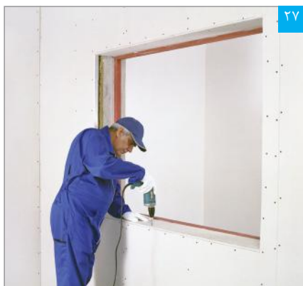
اتصال پنل نواری به سازه قاب‌بندی تحتانی
