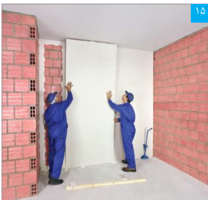
۱۵ پنل‌ها بر روی محور مرکزی کرم‌ها مستقر می‌شوند
