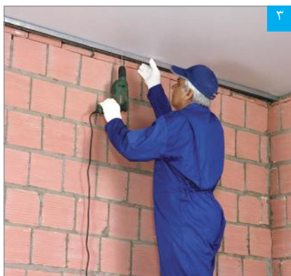
۳ نصب سازه هادی سقف
