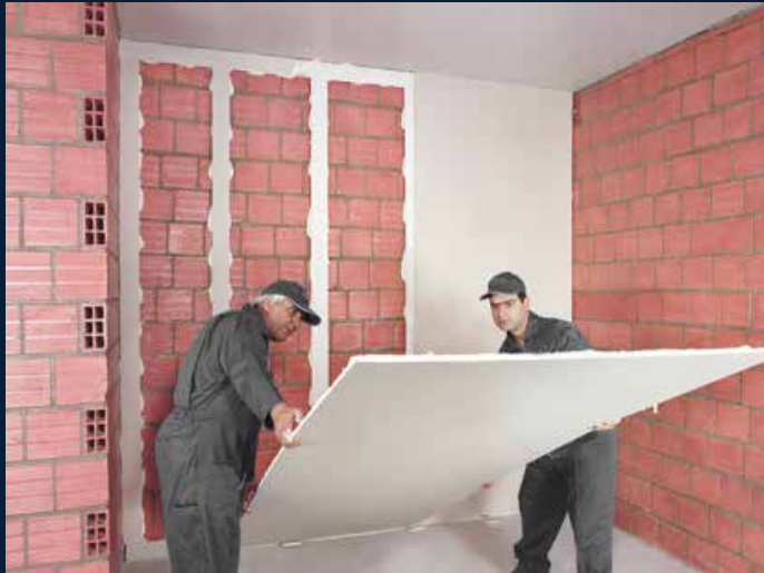
دیوارهای پوششی بدون سازه
